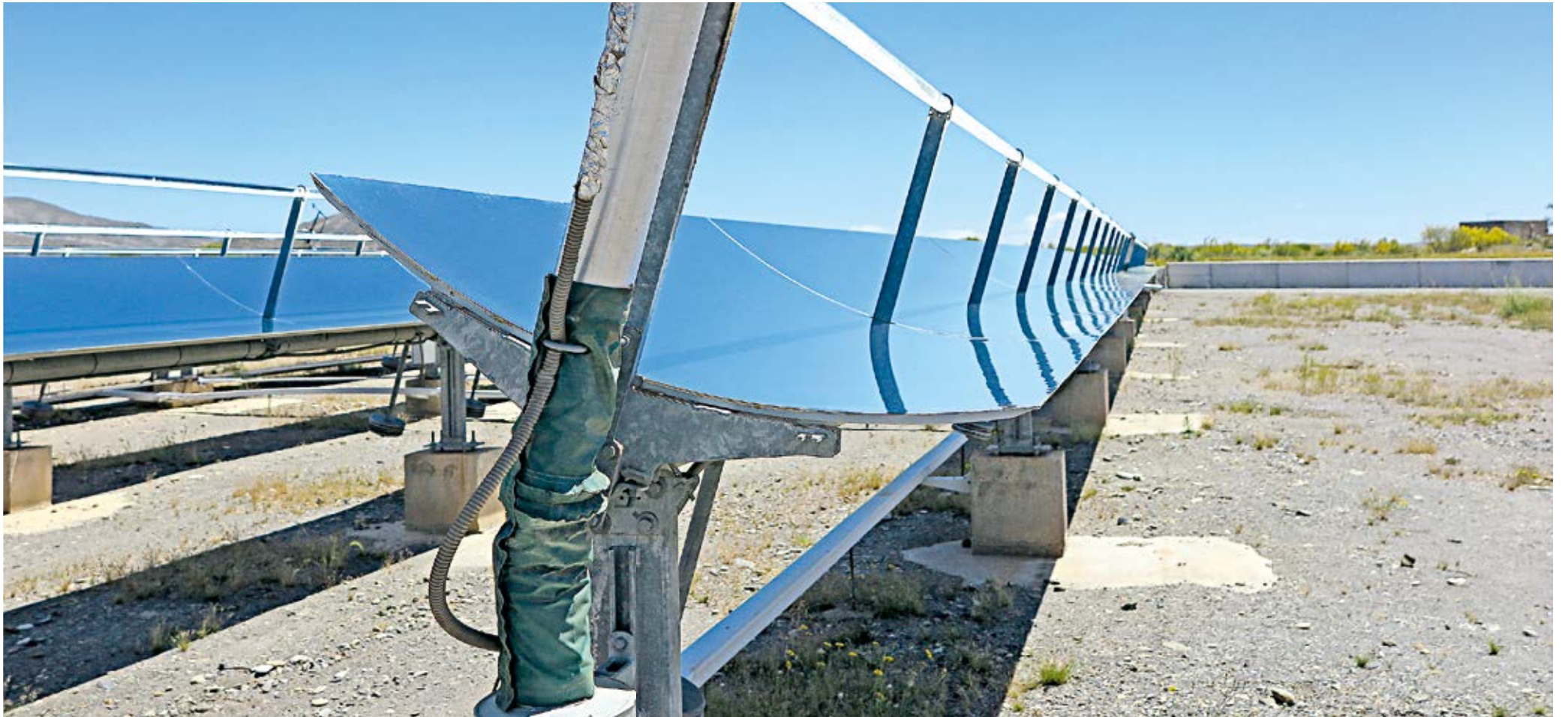
(kw) Mit großen Solarrinnen wird die Energie der Sonne zu 80 % übertragen und steht so der Solaren Meerwasserentsalzung zur Verfügung. In der Mitte (im Bild oben) das Rohr mit dem Energieträger.
